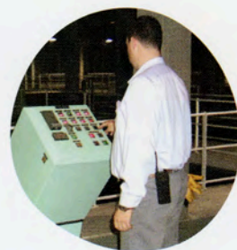
Instal·lació de filtració per carbó actiu.
