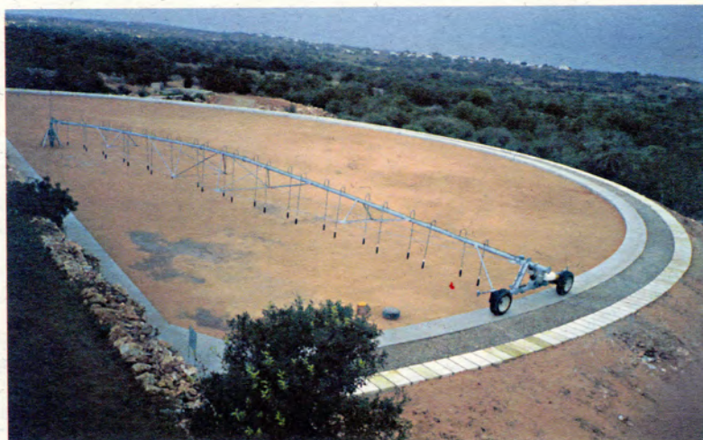
Vista general de la planta de tractament terciari per infiltració-percolació a Sant Lluís (Balears)
