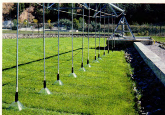
Vista general de la bassa d'infiltració-percolació i detall dels aspensors de la planta de tractament terciari de Piera (Barcelona)
